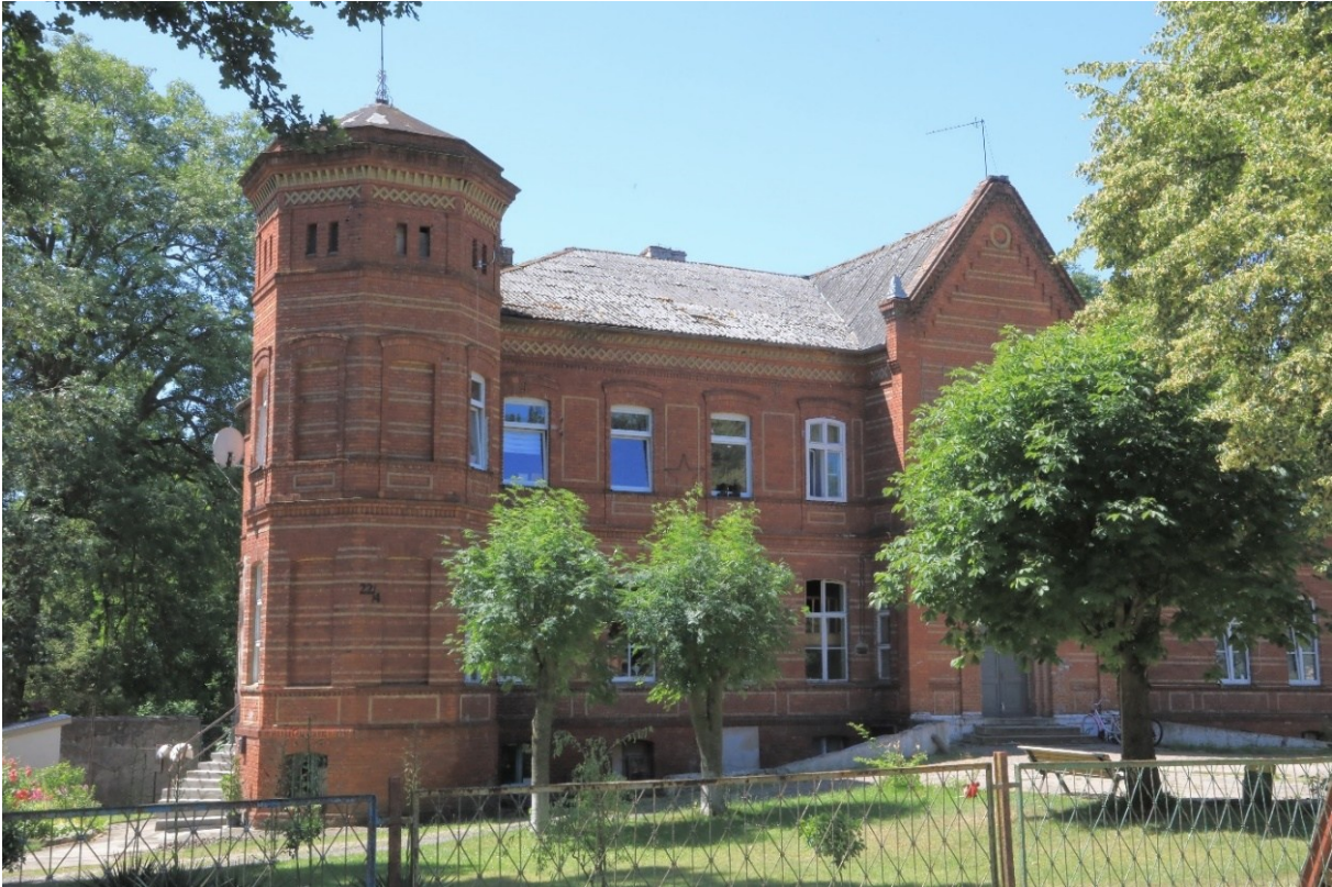
Gegenüber der Kirche liegt das ehemalige Herrenhaus des früheren Gutes Lübtow B, das zu einem großen Teil erhalten und heute in Wohnungen aufgeteilt ist. (Foto: Andreas Bödecker, 2025)
