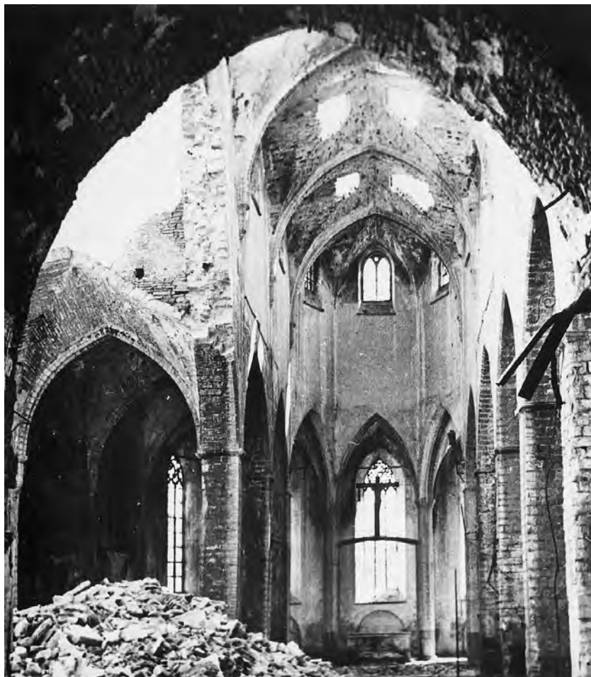
Abb. 3: Die St. Nikolaikirche in Tallinn nach dem Zweiten Weltkrieg. Foto vom Beginn der 1950er Jahre. Regen und Eis brachten die nach der Bombardierung vom 9. März 1944 noch stehenden Gewölbe zum Einsturz. Foto im Besitz des Autors.
