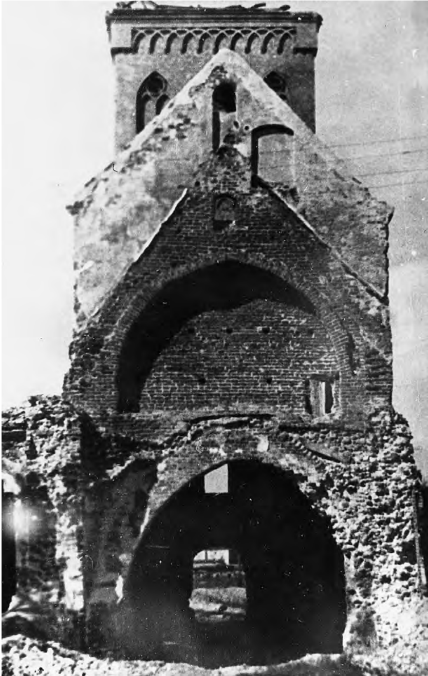
Abb. 2: Ruinen der St. Nikolaikirche in Pärnu (Pernau) 1945. Quelle: Archiv des Estnischen Denkmalpflegeamtes.
