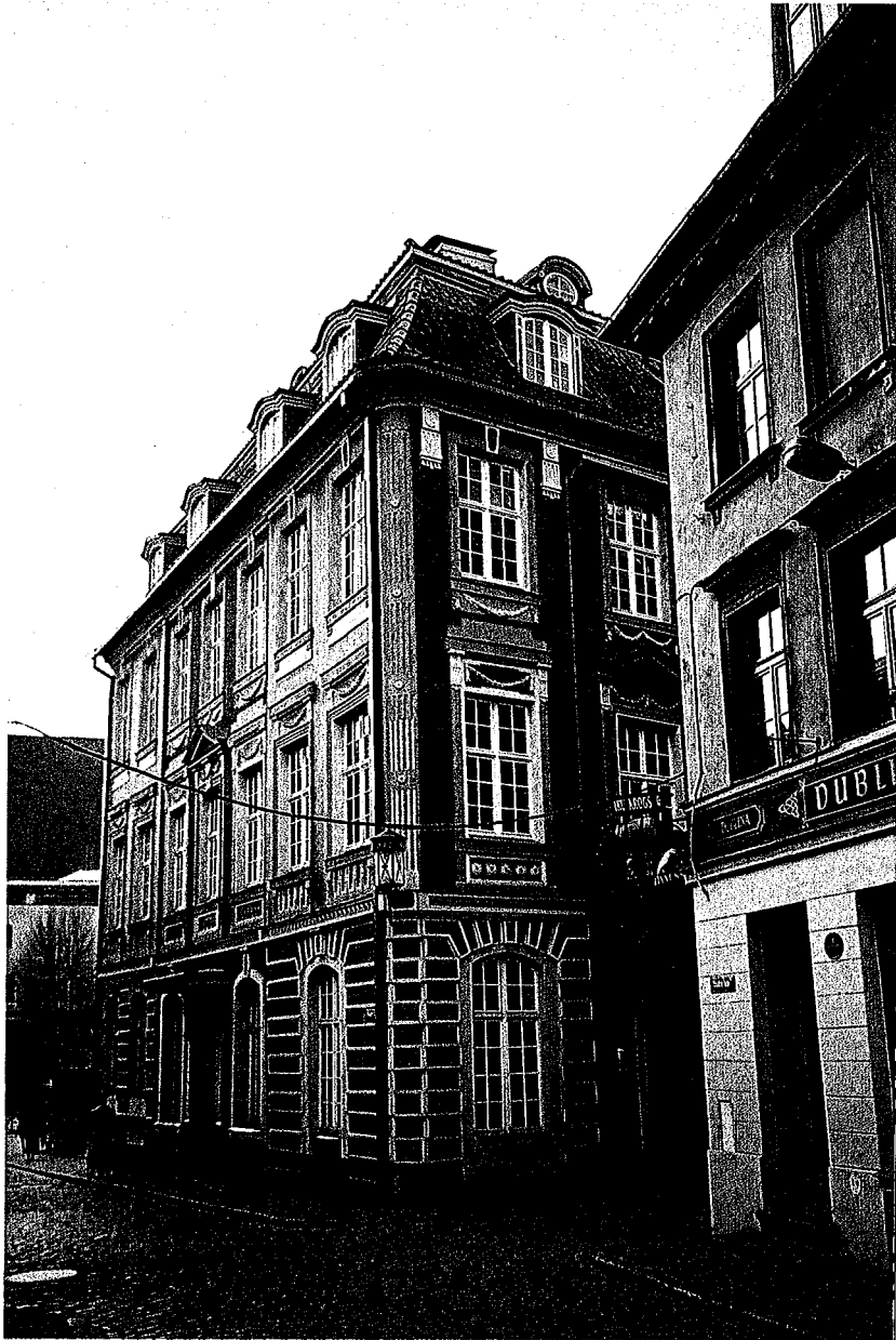
Abb. 2: Wohnhaus in der Teātra-Straße 6 (1785, Architekt [J.] Haberland). Foto: Jānis Zilgalvis
