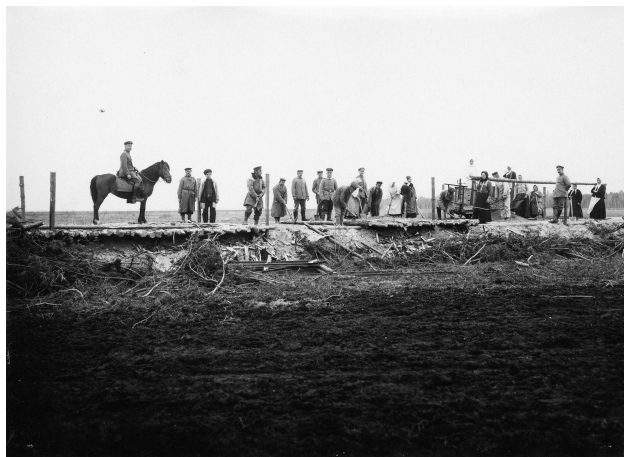
Abb. 2: Straßenbauarbeiten in den besetzten östlichen Gebieten. Erstaunlich ist der hohe Frauenanteil bei dieser schweren körperlichen Arbeit. 25
