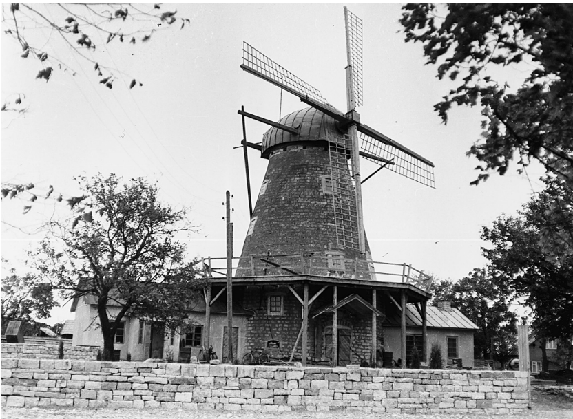
Abb. 8: Windmühle in Kuressaare (Arensburg) nach der Restaurierung als Restaurant im Jahre 1977. Quelle: Archiv des Estnischen Denkmalpflegeamtes.
