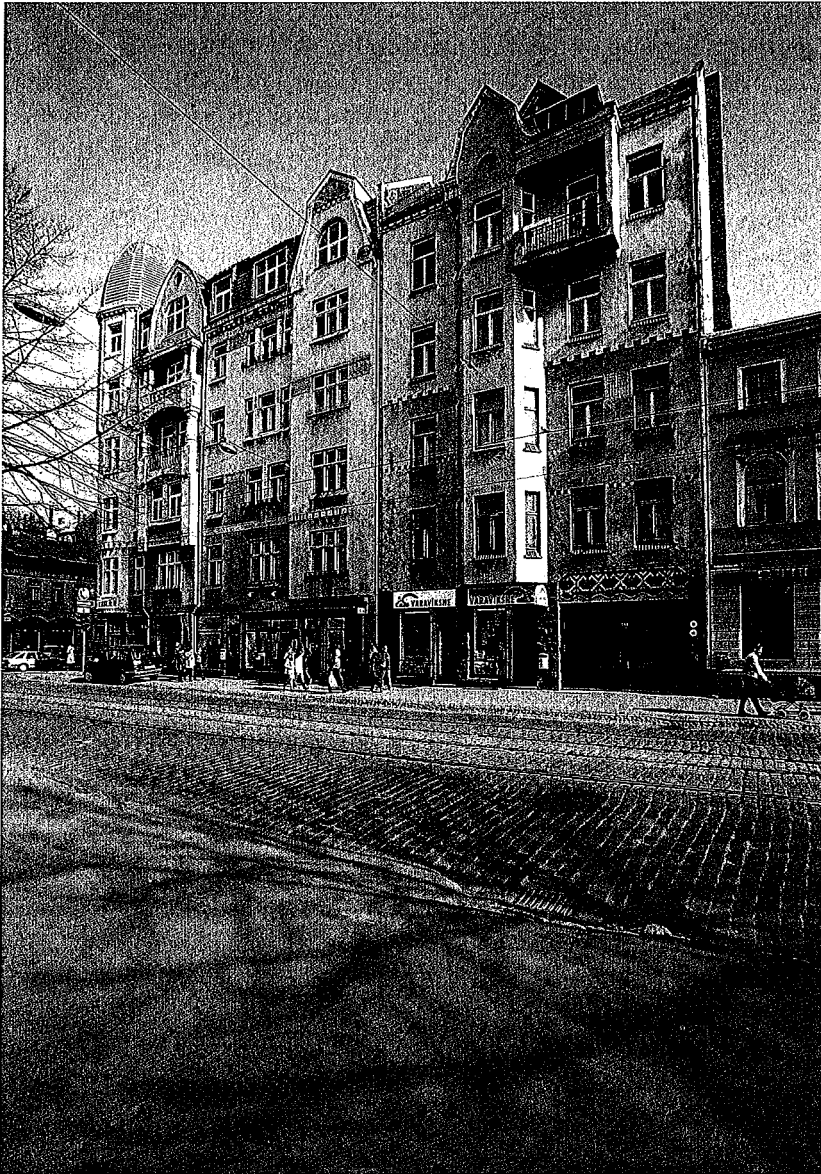
Abb. 4: Mietshäuser Krišjāņa-Barona-Str. 62, 64, erbaut 1909 und 1911, Architekt: Aleksandrs Vanags (Nationalromantik). Foto: Jānis Krastiņš
